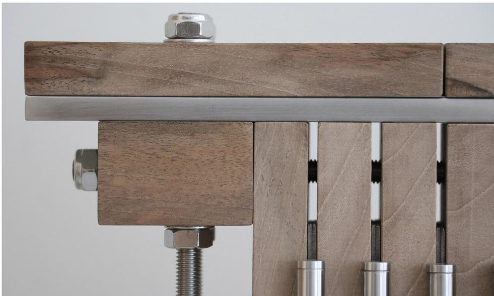
Detalle. Montajes Construxistas: Serie Bisagras 001.
